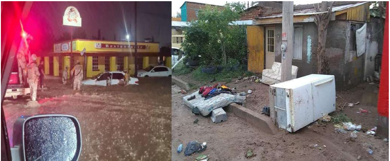
Figura 24.- Se muestran parte de los daños generados por la presencia de Inundaciones y Vientos fuertes en el Municipio de Agua Prieta
